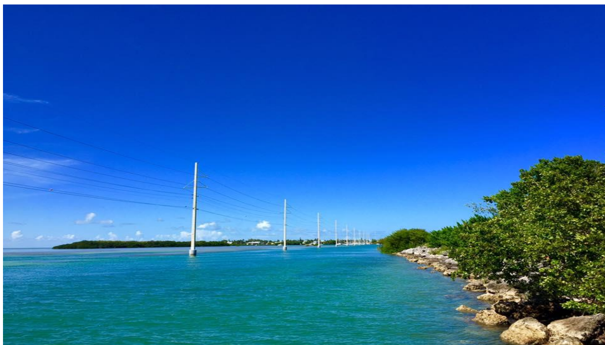
Dech beroucí cesta na Key West – dlouhé mosty, sloupy elektrického vedení stojí v oceánu a vodní hladinu máte doslova na dosah ruky.
